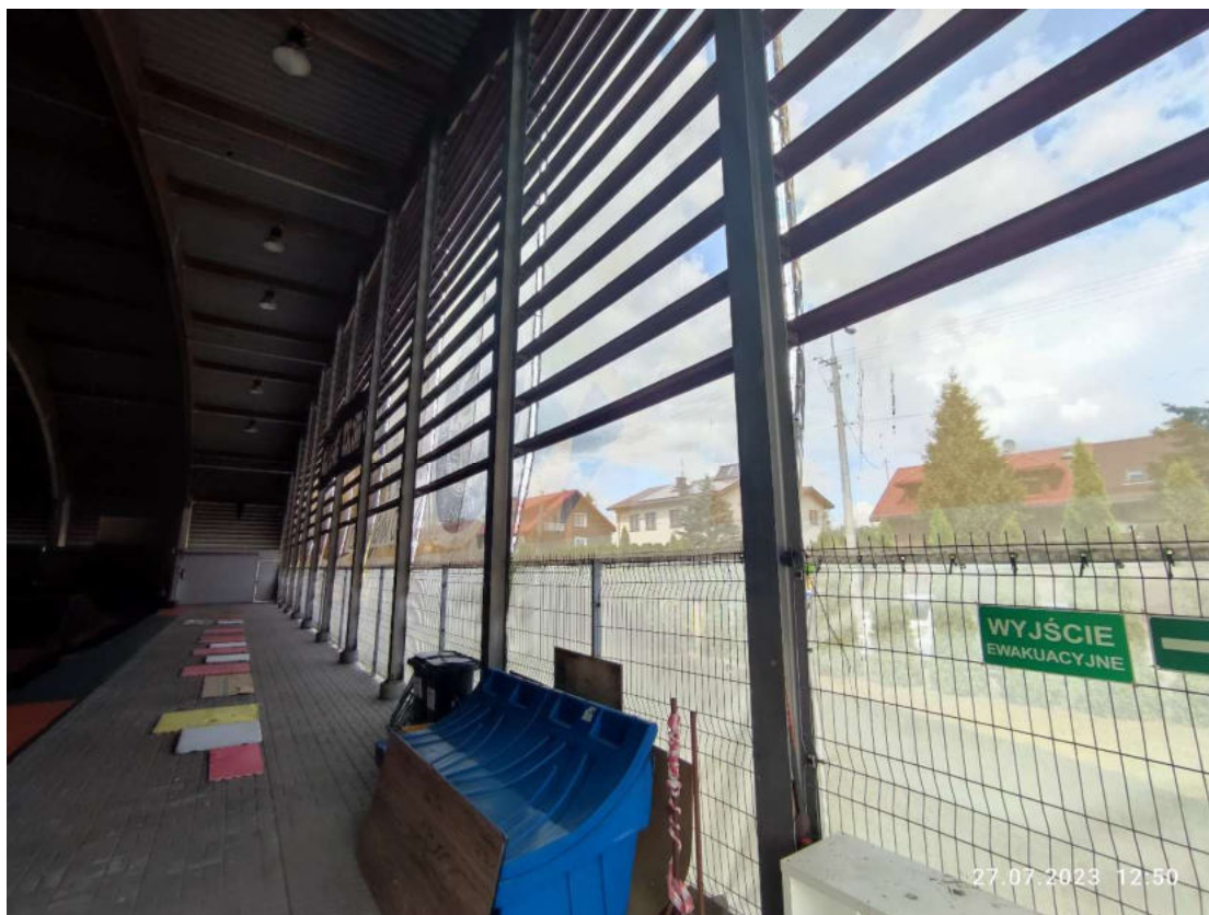
RYS. NR 2 – Widok ściany szczytowej hali lodowiska/boisk wielofunkcyjnych od wewnątrz
