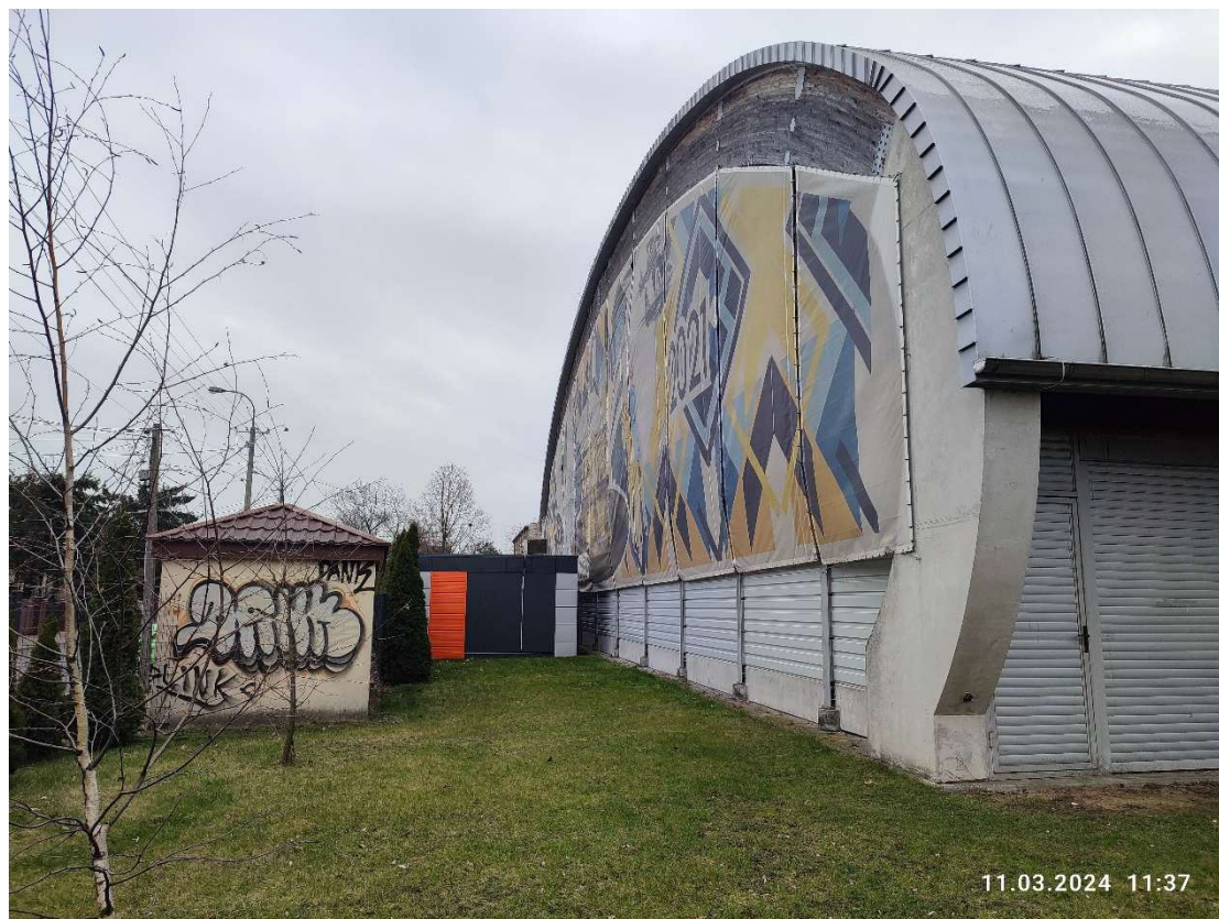
RYS. NR 2 – Widok kształtu ściany szczytowej hali lodowiska/boisk wielofunkcyjnych obiektu
