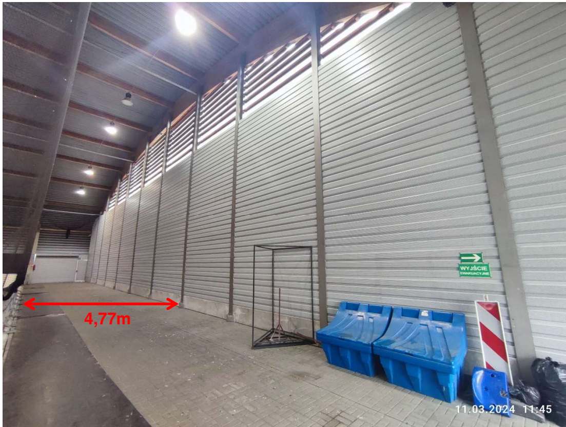
RYS. NR 3 – Widok ściany szczytowej hali od wewnątrz budynku
