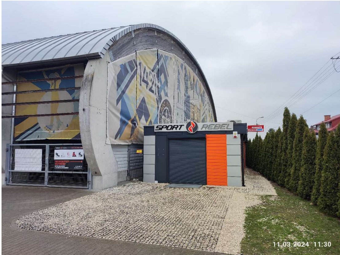
RYS. NR 1 – Widok kształtu ściany szczytowej hali lodowiska/boisk wielofunkcyjnych obiektu
